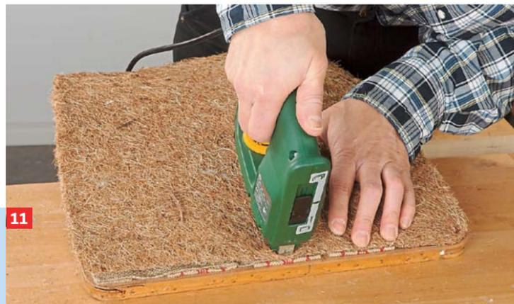
**11** Zum Befestigen benötigen Sie jetzt bereits 12 bis 14 mm lange Tackerklammern.
