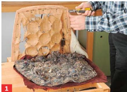
**1** Die alten Polsterlagen müssen komplett runter – Nagel für Nagel, Schicht für Schicht wird der Holzrahmen freigelegt.
