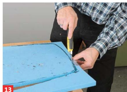
**13** Im Anschluss folgt die Schaumstoffmatte. Auch sie wird mit dem Cuttermesser auf das Rahmenmaß zugeschnitten.
