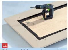
Rahmen und Polster ausrichten, vorbohren, senken und verschrauben. Halteleiste an die Wand dübeln und Kopf einhängen
